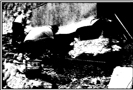
Si lavora al pilastro anteriore sinistro per porvi l'armatura di rinforzo.
